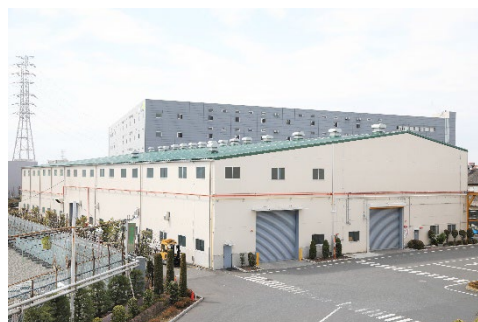
※2 第三圧延工場外観
